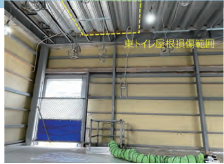
爆発事故でトイレの天井に10箇所の凹み「床100㎡の損傷」との事故報告から2月後、爆発の激しさを物語っています。
