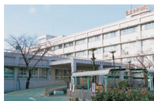
つぶされた住吉市民病院
