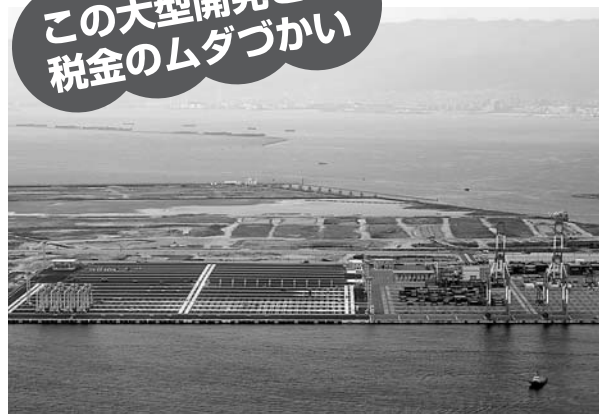
夢洲に建造中のスーパー中枢港湾(720億円も注ぎ込む見込み)。沖合は現在、工事が休止となっている新人工島(2009年度までに1,230億円を投資)。
